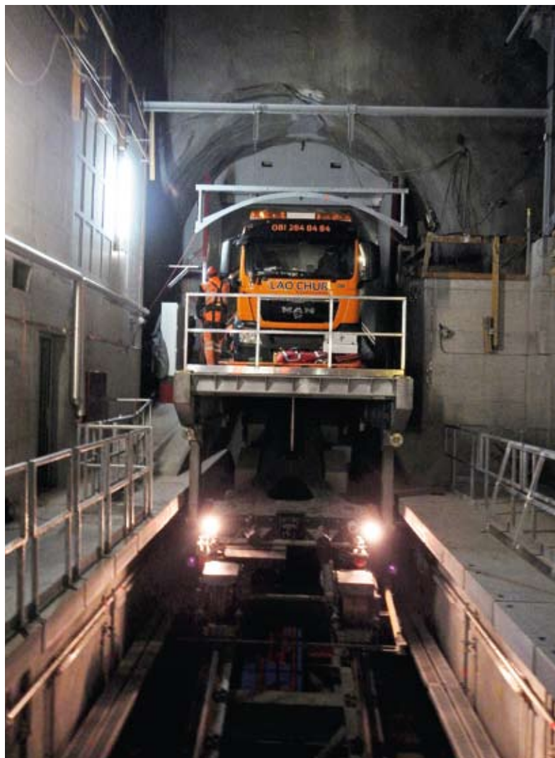
Während der Arbeit bleibt das Fahrzeug auf der Bahn stationiert.
